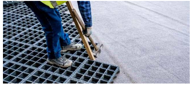
Užtikrinkite tvirtą įrengimą ir reguliarių įspaudimų, siekiant užkirsti kelią tarpų formavimuisi ateityje
