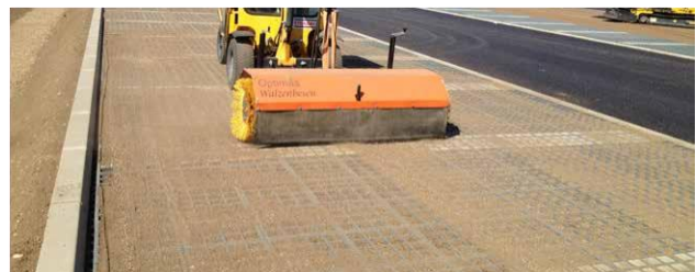
Nevisiškam užpildymui užtikrinti naudokite šluotą
