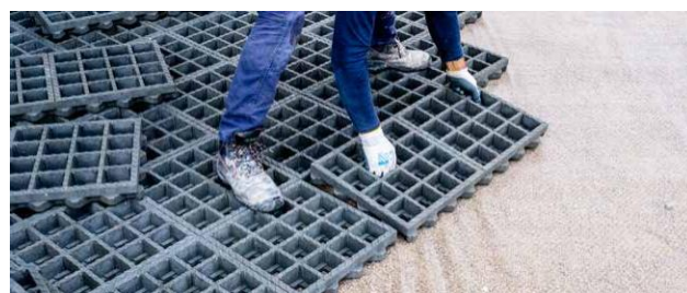
TTE® elementų klojimas ant plono tinklo
